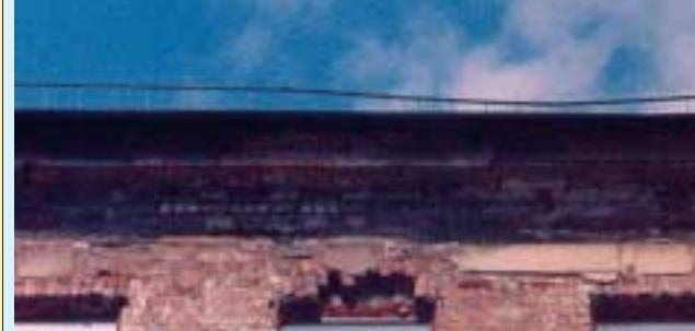
Примеры разрушения вследствие действия влаги и изменения температур не защищенных: настенного покрытия здания (вверху), кирпичной кладки (вверху и внизу слева) и асфальта (внизу слева).
